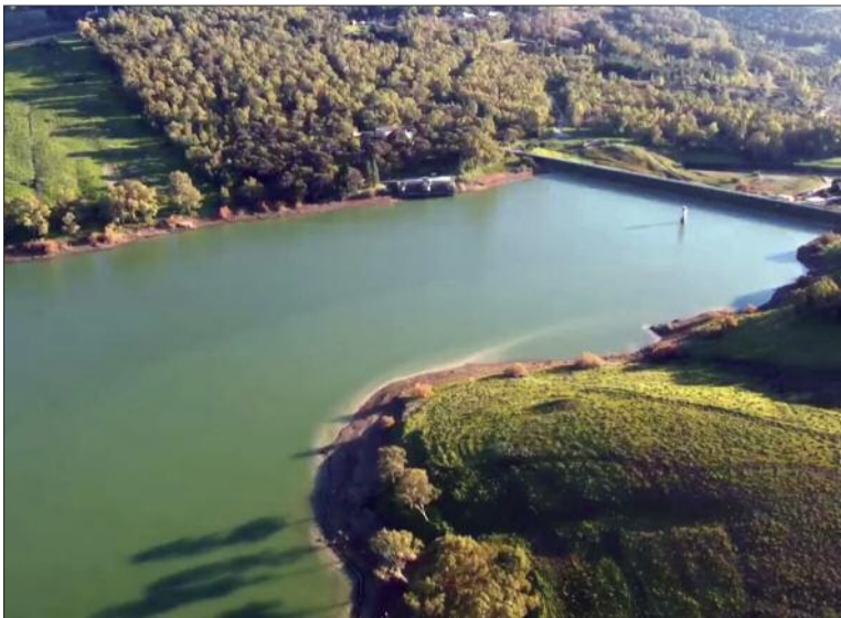
La diga Trinità; a destra l'acqua in eccesso viene sversata
