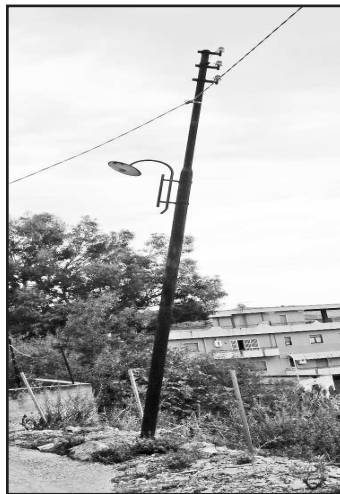
La strada lesionata con il muro di sostegno crollato e il palo in procinto di cadere
