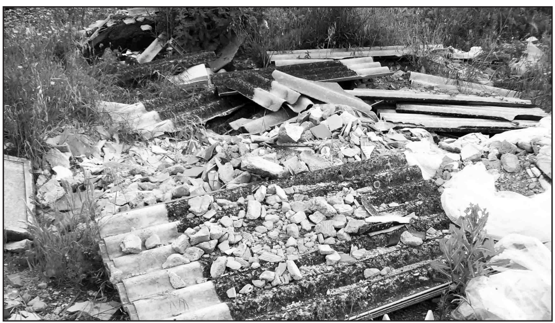
Eternit abbandonato nelle campagne
