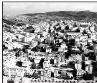
Panoramica di Santa Ninfa
