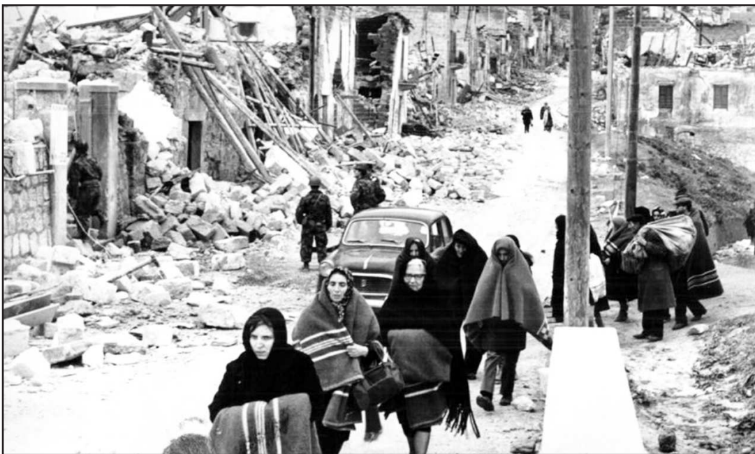
La fuga dai centri distrutti dal terremoto; a destra la Chiesa Madre di Salemi viene demolita
