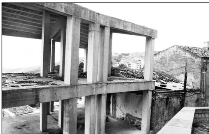
Un fabbricato incompleto nel cuore del centro storico
