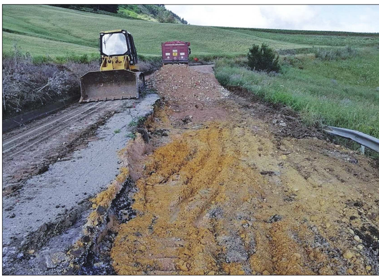
Sopra e a destra i lavori nelle stadi extraurbane
