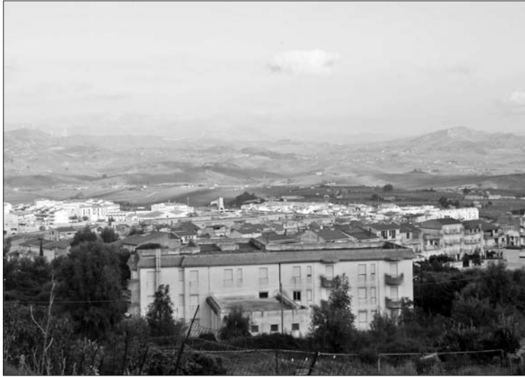
La contrada Sasi; a destra l'impianto di illuminazione della zona
